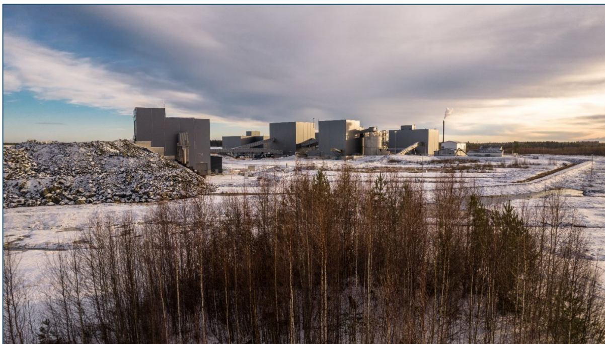
Figur 3. Området vid anrikningsverket i Päiväneva i början av 2026. © Keliber
