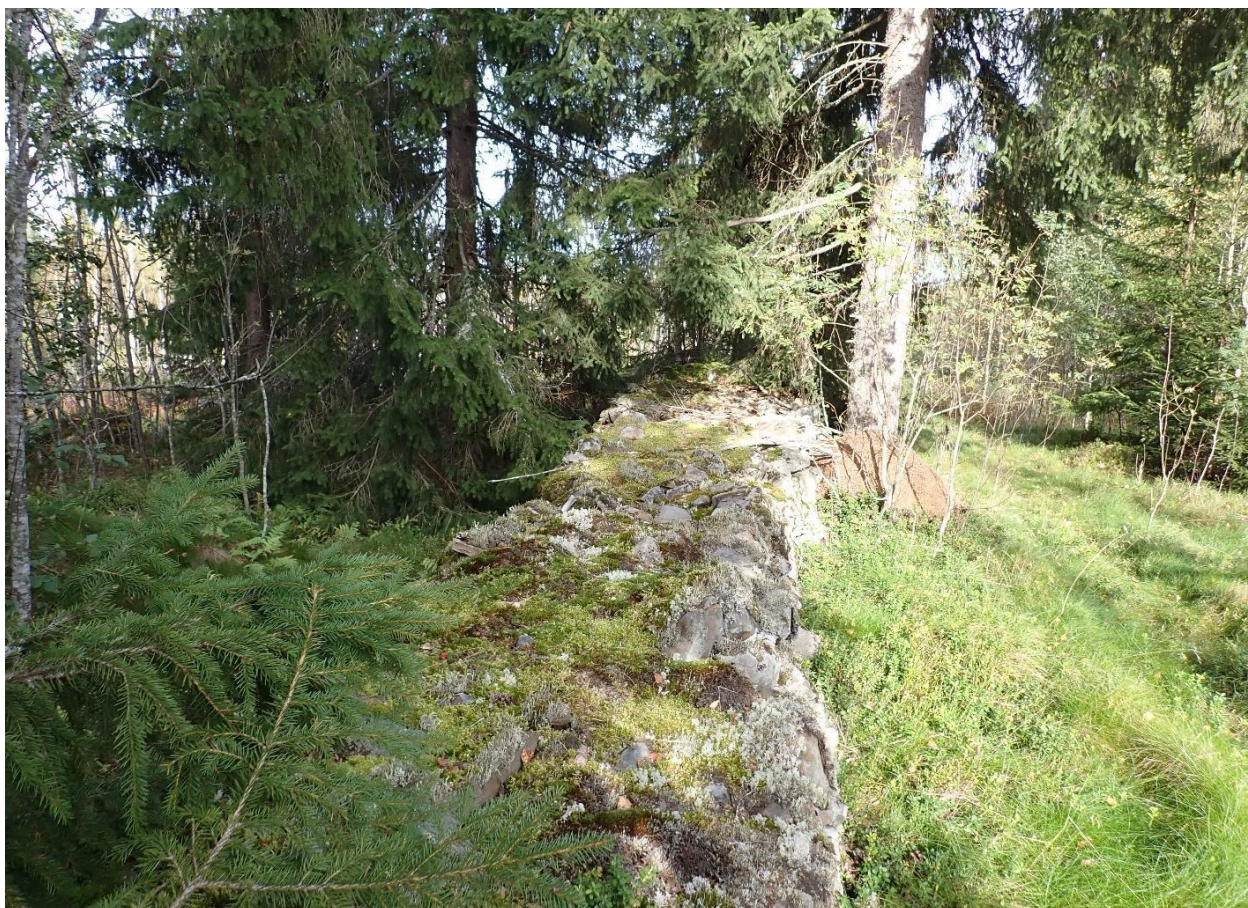
Bild 14. Ett stengärde på elöverföringslinjen vid Vattumossavägen. Bild mot sydost.
