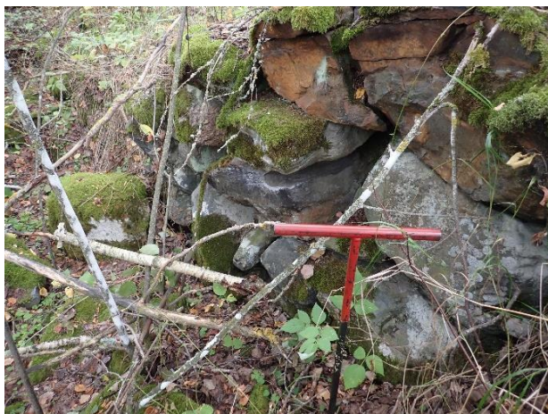
Bild 35. Källarvägg av naturstenar.
