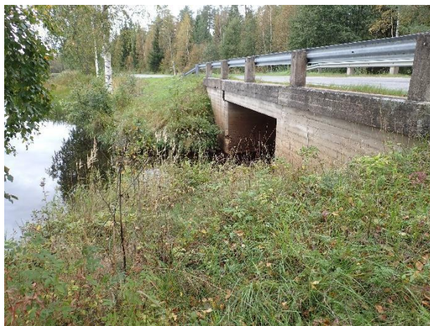
Bild 38. Den moderna bron över Svartbäcken är byggd av betong. Det syntes inga tecken på någon äldre konstruktion. Bild mot nordost.
