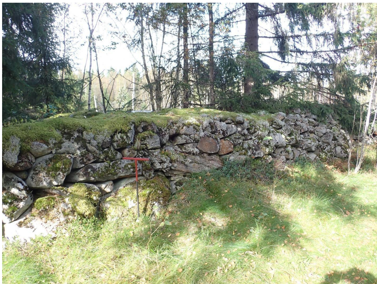
Bild 13. Ett stengärde på elöverföringslinjen vid Vattumossavägen, cirka 70 meter väster om Kaitåsvägen. Z 75. Bild mot nordost.
