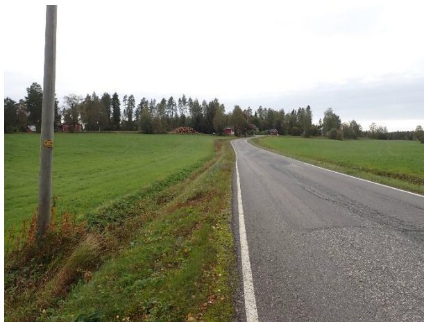
Bild 31. Elöverföringslinjen vid Småböndersvägen norr om Myngelssjön. Terrängen i området är svagt sluttande med välskötta gårdsplan och åkrar som växer gräs. Bild mot nordväst.
