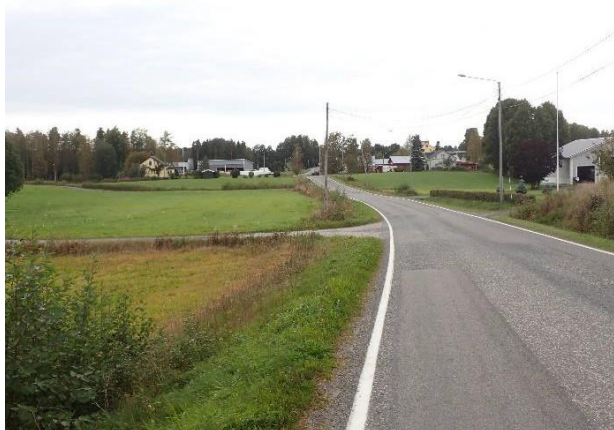
Bild 32. Elöverföringslinjen vid Småböndersvägen vid Papas. Terrängen i området består av flack och svagt sluttande åker som växer gräs. Bild mot nordväst.
