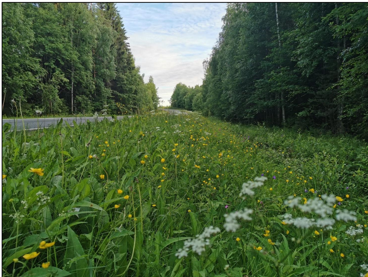
Figur 3. Vägkant från den södra jordkabelsträckningen.
