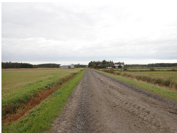
Kuva 25. Sähkönsiirtolinjaa Ollasmosantien varressa, Ollasmossenin lounaispuolella. Maasto alueella on tasaista nurmella olevaa peltoa. Z 67,5–70. Kuva luoteeseen.
