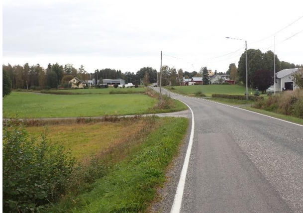
Kuva 32. Sähkönsiirtolinjaa Småböndersintien varressa Papaksen kohdalla. Maasto alueella on laakeaa ja loivasti viettävää nurmipeltoa. Kuva luoteeseen.
