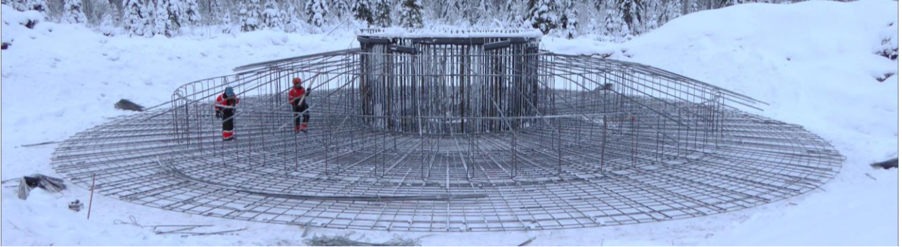
Kuva 1: Tuulivoimalan perustuksen raudoitus
